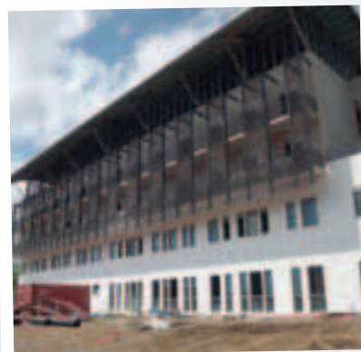
RESTAURANT DU PERSONNEL
