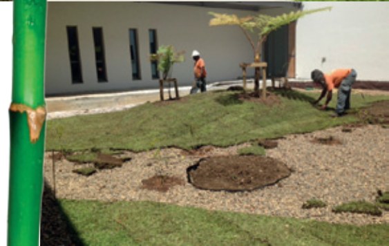
Ce chantier représente la plantation d'environ 400 palmiers, 600 arbres et des milliers d'arbustes et de plantes. Les espèces sont endémiques, indigènes ou exotiques, pour refléter la diversité de la Nouvelle-Calédonie, issue de millénaires d'échanges.
